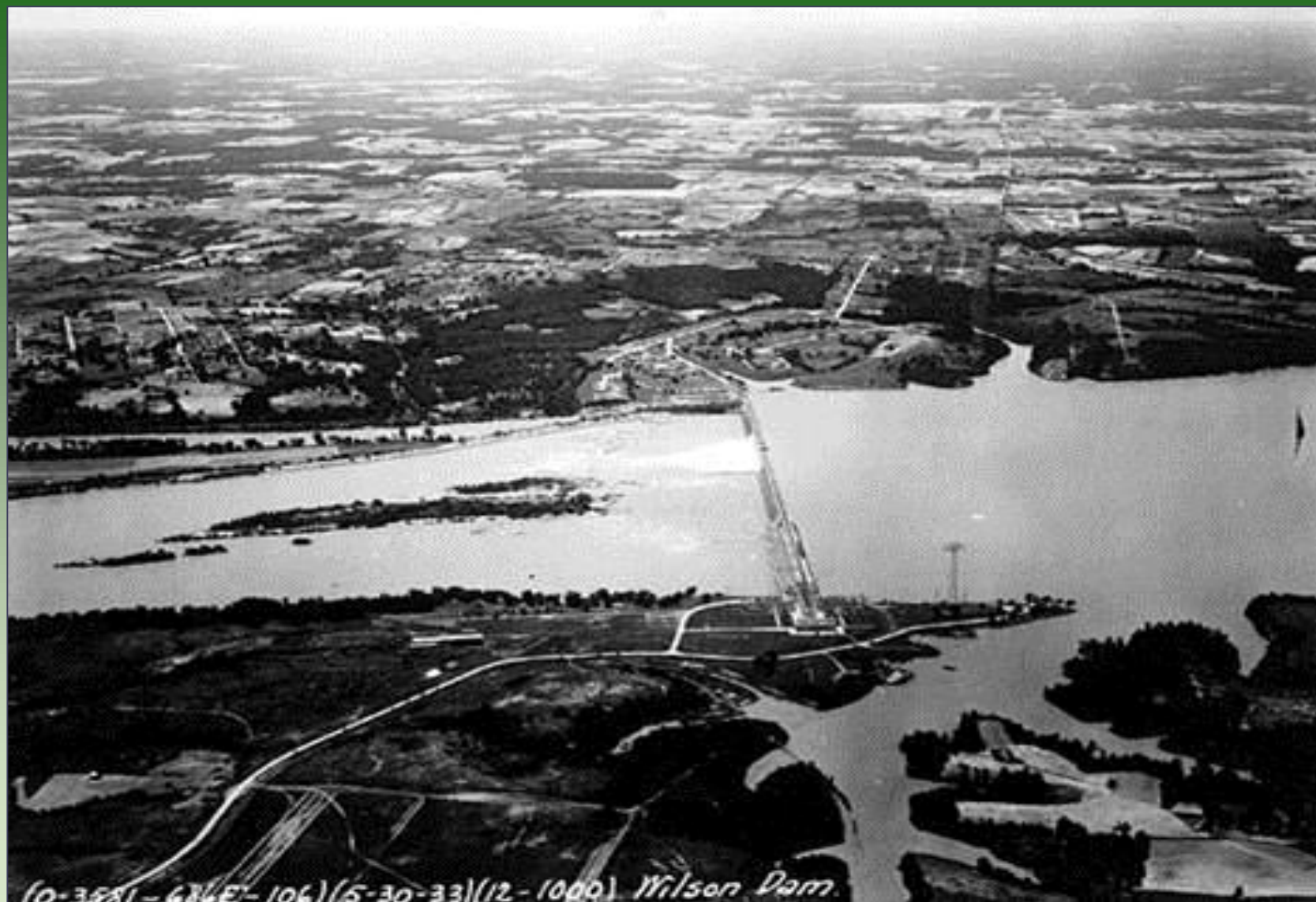
Construção da barragem de Wilson, no Alabama.
